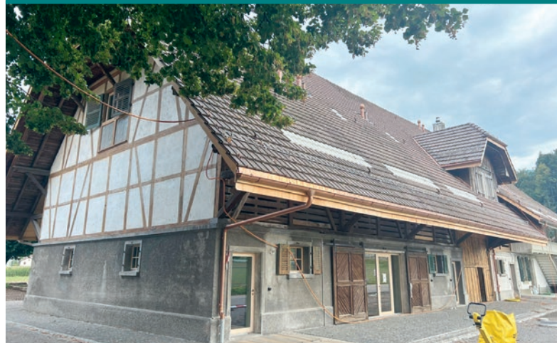
Ramseier Bauunternehmung AG Umbau
